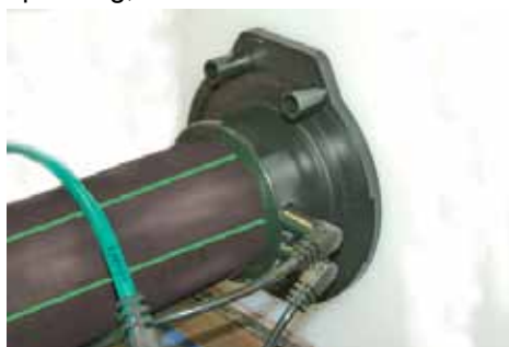
Afbeelding 13: Koppeling lassen
