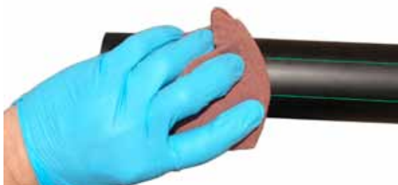
Afbeelding 11: Leiding reinigen
