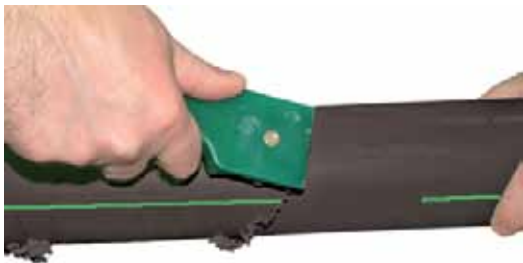
Abbildung 10: Rohr abschaben
