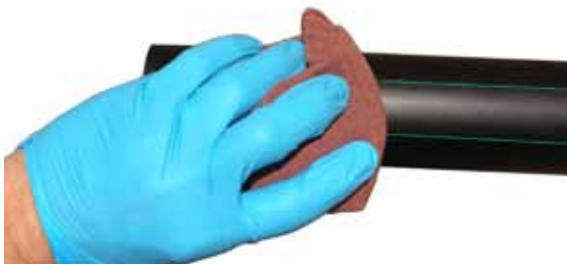
Abbildung 11: Rohr reinigen
