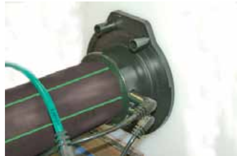
Abbildung 13: Schweißkupplung
